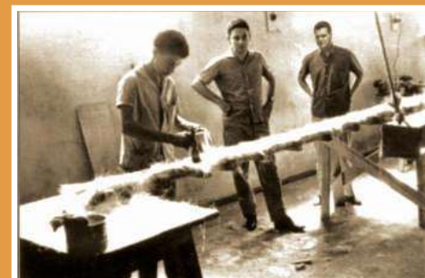
Na fundação, em novembro de 1965
